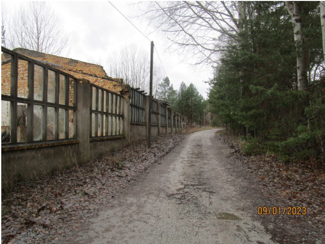
Abbildung 4: Blick auf Gebäudebestand der ehemaligen SERO-Annahmestelle und private Verkehrsfläche
